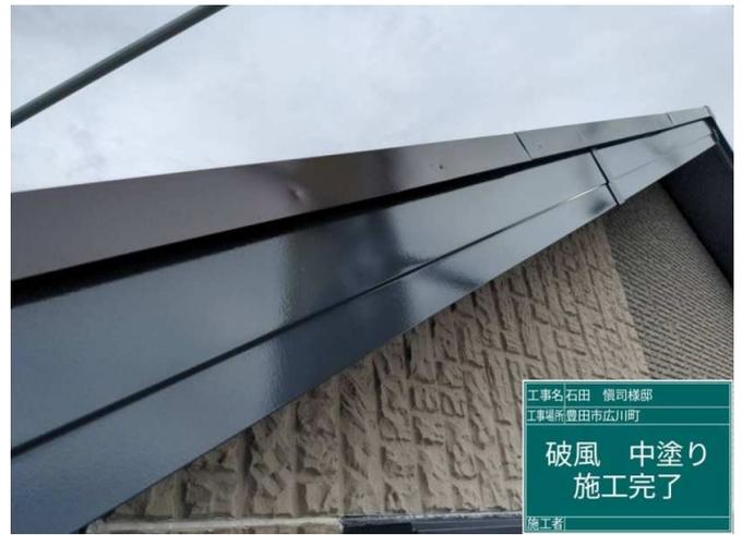
32 破風板 中塗り 施工完了
