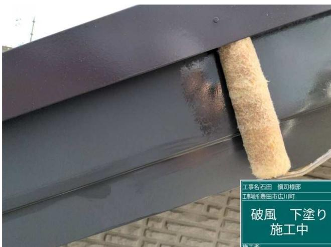
29 破風板 下塗り 施工中
