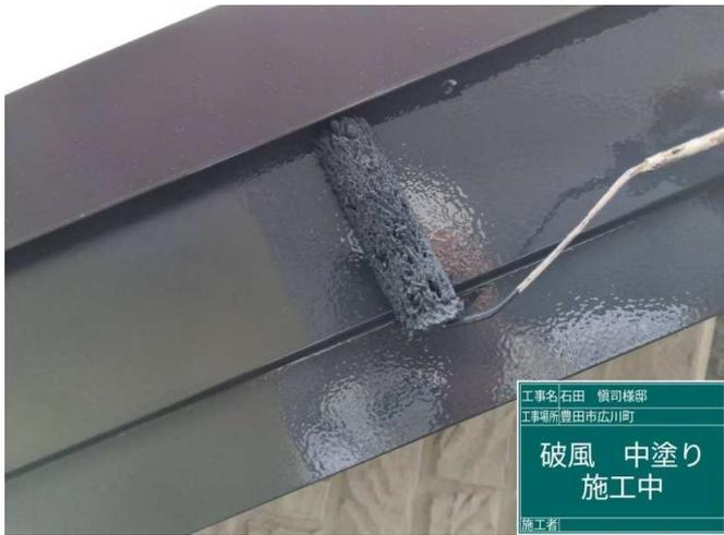
31 破風板 中塗り 施工中
