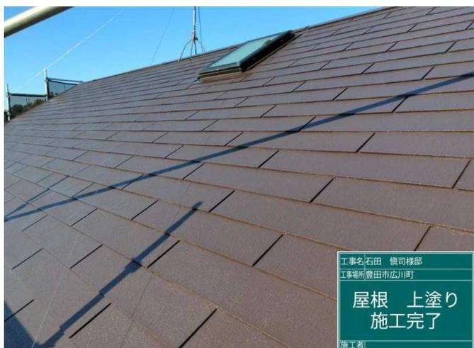
54 屋根 上塗り 施工完了
