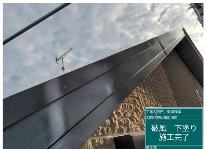
30 破風板 下塗り 施工完了
