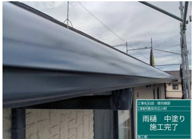
26 雨樋 中塗り 施工完了
