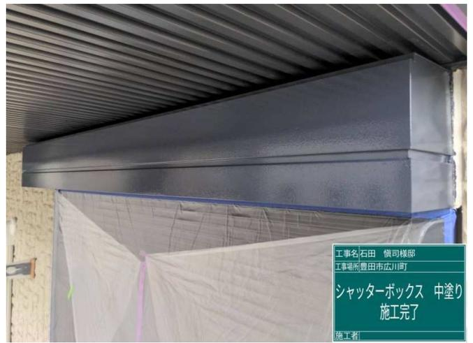
38 シャッターBOX 中塗り 施工完了
