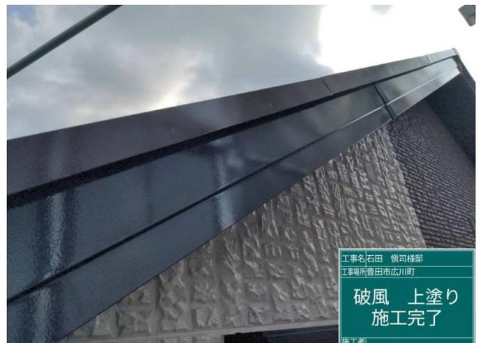
34 破風板 上塗り 施工完了
