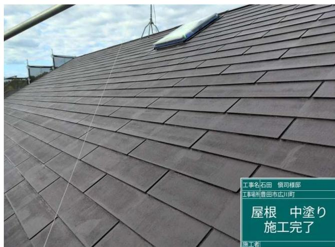
52 屋根 中塗り 施工完了
