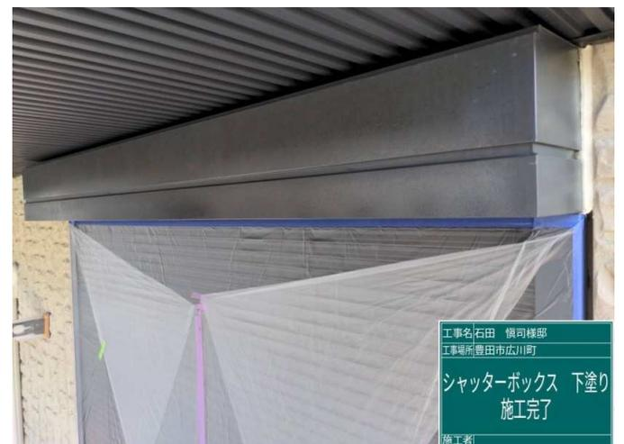
36 シャッター-BOX 下塗り 施工完了
