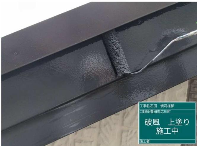
33 破風板 上塗り 施工中
